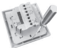
Рисунок 5. Демонтаж лицевой панели
